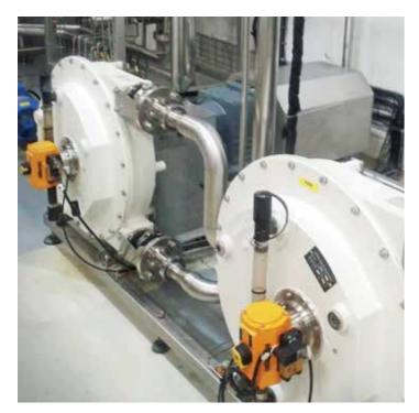
Le pompe a membrana, a lobi o a cavità progressiva necessitano di frequente manutenzione e non possono competere con l'affidabilità 24 ore su 24, 7 giorni su 7 delle pompe a tubo rinforzato Bredel.
